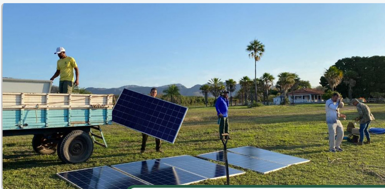
Instalação de painéis solares para bomba de captação de água
